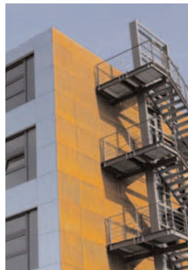
HOCH HINAUS: Ein Gebäude, das Akzente setzt – die moderne Unternehmenszentrale der STP Informationstechnologie AG in der Karlsruher Südweststadt.
